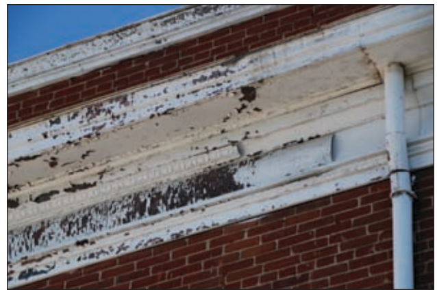
L'application d'une bonne couche de peinture pourrait améliorer le détail architectural et l'apparence générale de ce site.
